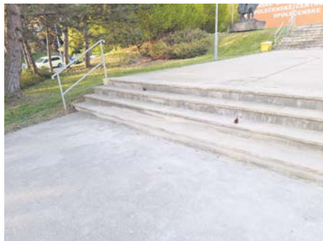
Schody Společenské centrum po opravě
